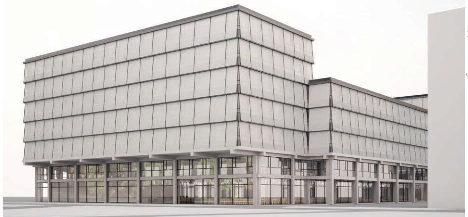
Bild 1: Planung einer Sonnenschutzanlage für eine komplexe Gebäudestruktur / Systeme hier geschlossen (Entwurf: welter & welter architekten bda / berlin).
